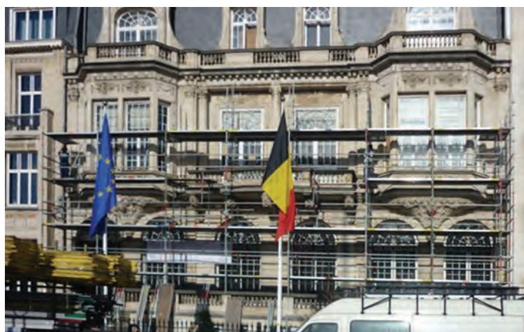
Les échafaudages devant la façade de Delen - Private Bank - Bruxelles en janvier 2011
