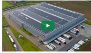
Die Solaranlage auf dem Dach der Firma E. Weber & Cie AG in Dietsdorf produziert mit 7800 Panels ca. 2,5 Mio. kWh im Jahr.
