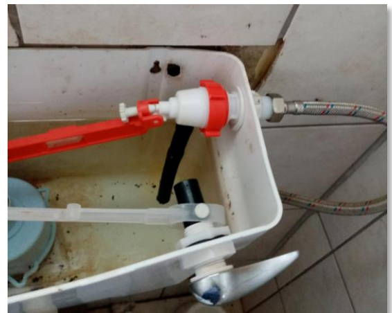
Repaired Toilet cistern
